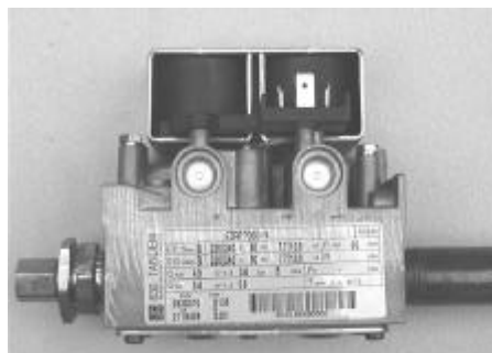
PICTURE 8 Gas Valve (UDSA models 008 - 030)
